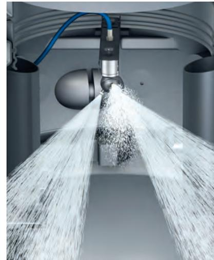
Hochdruckinnenreinigung bei einem Fettabscheider zur rückstandsfreien Entsorgung
